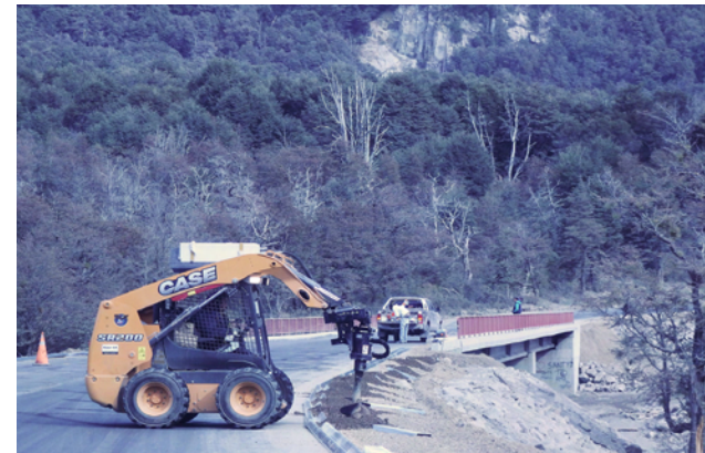
Perforación de banquina en la ruta de los 7 Lagos.
